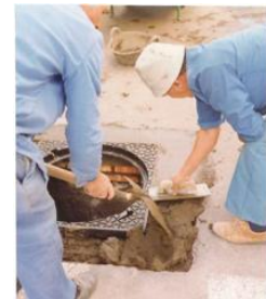
Foto 6. Relleno con REPARCROM AR 350 .
