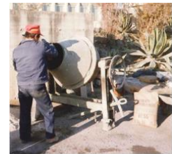
Foto 4. Mezclado de REPARCROM AR 350 .
