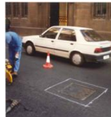
Foto 1. Área de reparación.
