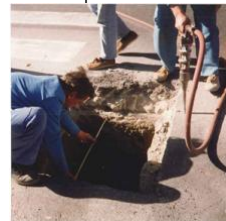
Foto 3. Limpieza y cubicación.
