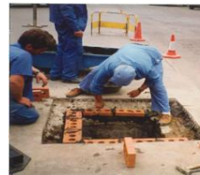
Foto 5. Enladrillado de base.
